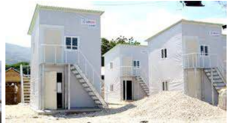
Haïti 2010 Ossature métallique
