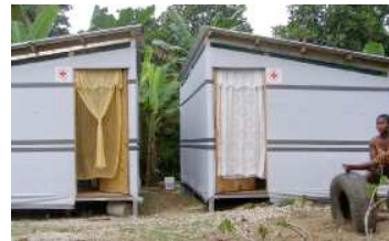
Haïti 2010 Ossature métallique
