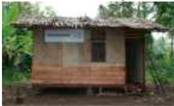
Indonesia_Soumatra 2009 Ossature Bois
