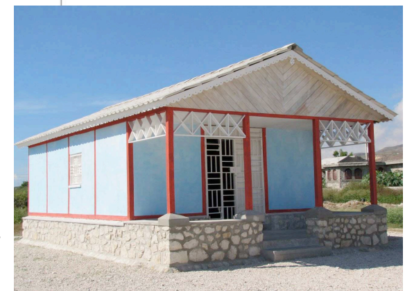
Chantier pilote, pépinière d'entreprises à Camp Corail, Haïti par Entrepreneurs du Monde
