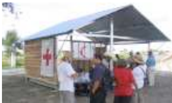
Indonesia_Aceh 2005 Ossature métallique
